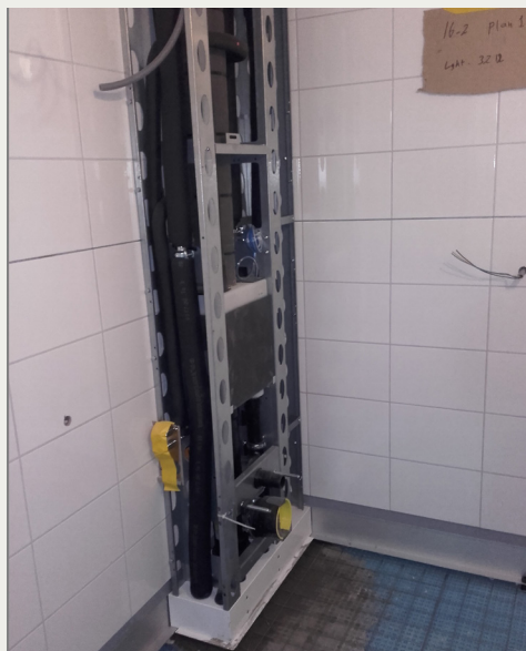
Prefabricerat helt schakt.
